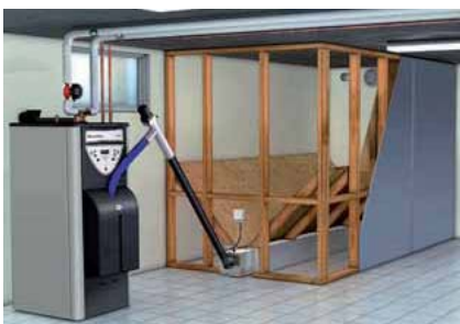
Silo de obra con tornillo sinfín de extracción y tornillo de alimentación.
