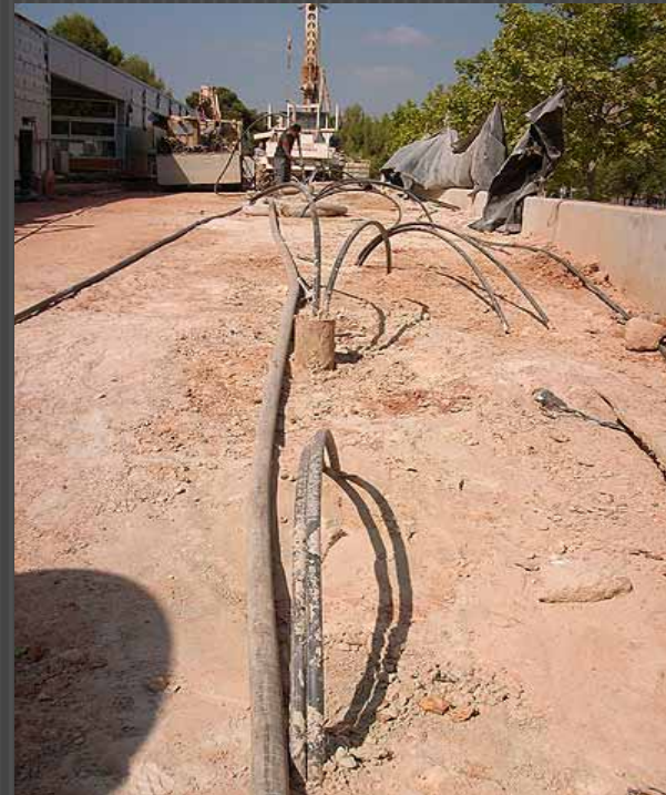
Perforaciones en instalaciones geotérmicas
